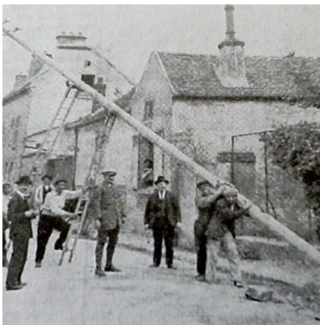
ILL.- 10.- INSTALLATION DE L'ELECTRICITE À L'HERMITAGE JUIN 1923
